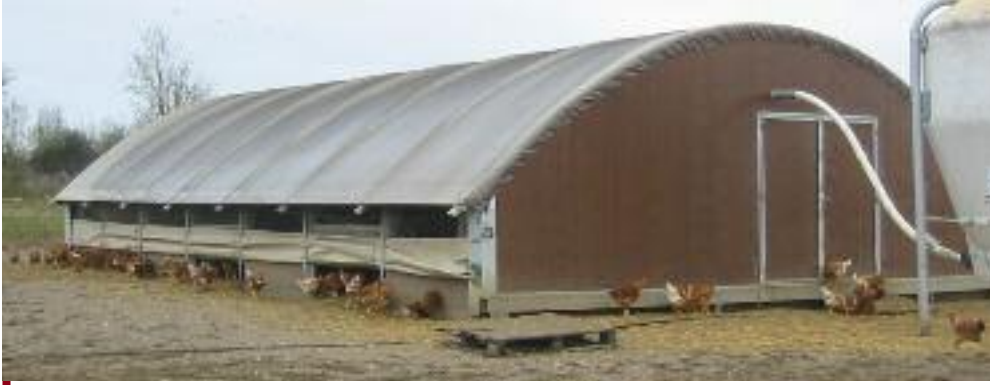
L'emplacement des bâtiments est choisi en fonction du sens du vent (Sud-Ouest) et de l'ensoleillement.
