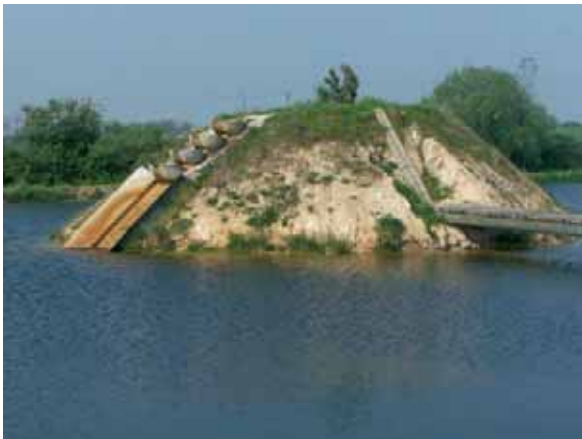
Au centre d'une réserve d'eau creusée de 20 000 m 3 , sur une île, des vasques vivifient l'eau. Cette eau est utilisée en fin d'été pour préserver la nappe. La plupart des vergers sont équipés d'un système d'irrigation au goutte à goutte, qui apporte en moyenne 5 mm d'eau par jour, de début juin à la mi-septembre.
