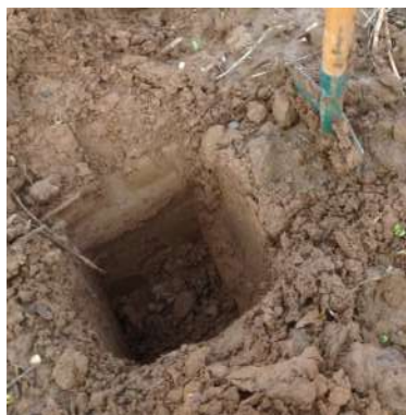
Figure 9: Réalisation d'une prétranchée
